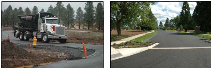
<그림 2-13> 세일럼 친환경 주거단지 시공 전·후 모습
