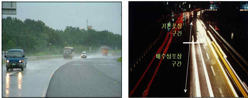
<그림 2-10> 물고임 및 물보라 방지효과와 난반사 방지 효과
