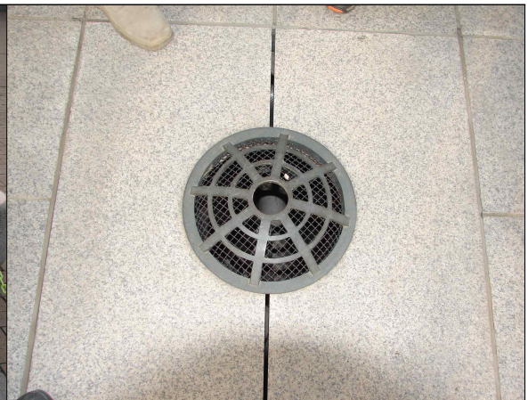
이물질 유입과 안전성이 낮은 돌출형 커버
