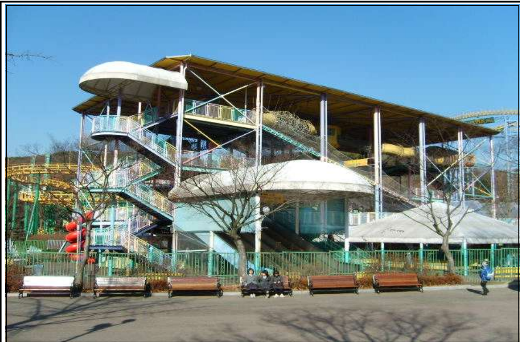
점검대상 건물 ⑤ (액션존)
