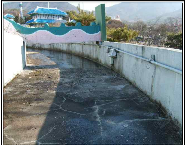
<사진 5-18> 지붕층 바닥 상부 방수모르타르 파손, 풍화 및 배수불량에 의한 물고임 현황
