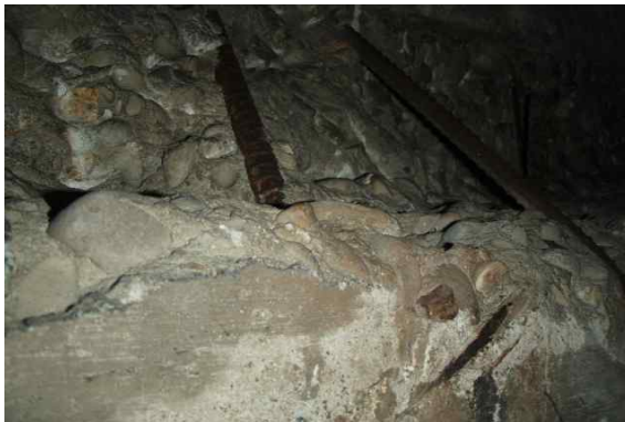
<그림 2.2-5> 도면 지하층 X3~4-Y3~4열 기존 구조체 철거에 의한 철근노출상태
