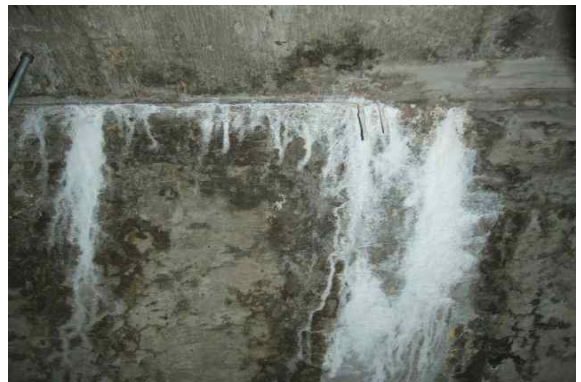
<그림 2.2-8> 도면 지하층 X1~3-Y2~3'열 외부 연결계단 보와 접합부 및 콘크리트 타설불량에 의해 재료분리가 발생된 슬래브 누수발생 상태
