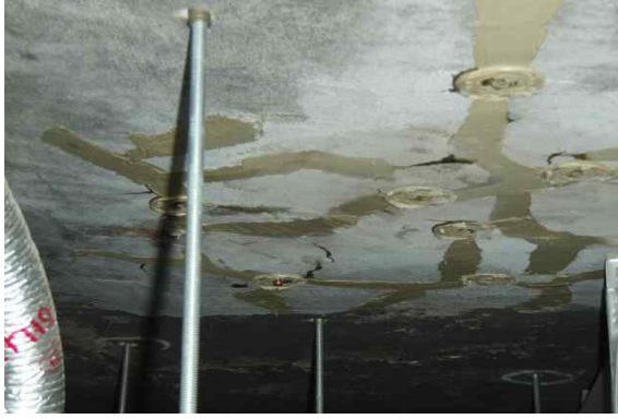
<그림 2.2-2> 도면 지하층 X19~20-Y2~3열 슬래브 균열 보수상태
