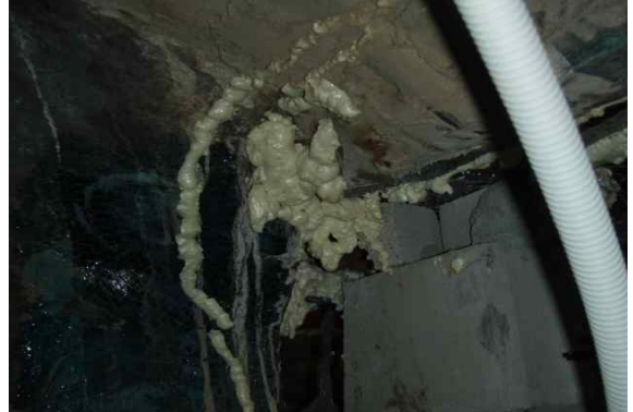
<그림 2.2-7> 도면 지하층 X1~2-Y11~12열 중앙 우체국과 연결통로 및 계단 천장 슬래브의 구조체간 접촉부위 및 신·구 콘크리트 접합부 누수발생 상태
