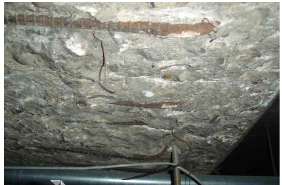
<그림 2.2-6> 도면 지하1층 X3~6-Y10~Y12열 기존 구조체 철거에 의한 철근노출상태
