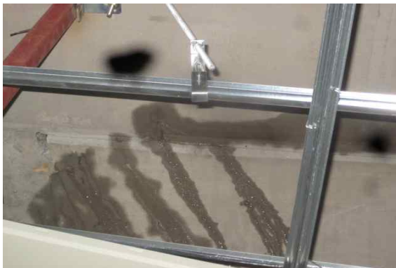
<그림 2.2-8> 도면 지하층 X1~3-Y2~3'열 외부 연결계단 보와 접합부 및 콘크리트 타설불량에 의해 재료분리가 발생된 슬래브 누수발생 상태
