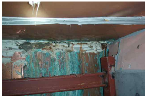
<그림 2.2-9> 도면 지하층 X16~18-Y1~3'열 신세계 백화점과 연결통로 구조체 접합부위 유도관(PVC관)과 배수관의 접합부위 누수 발생상태
