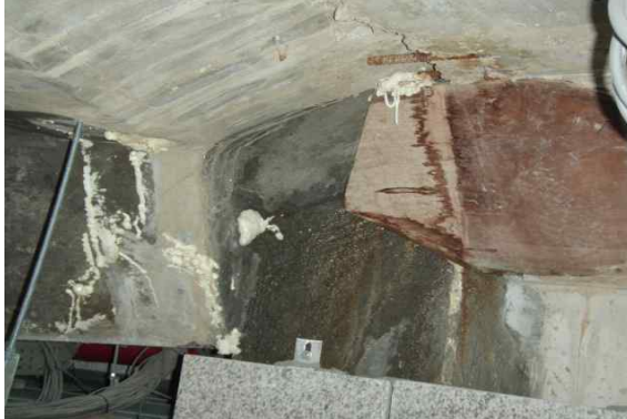
<그림 2.2-7> 도면 지하층 X1~2-Y11~12열 중앙 우체국과 연결통로 및 계단 천장 슬래브의 구조체간 접촉부위 및 신·구 콘크리트 접합부 누수발생 상태
