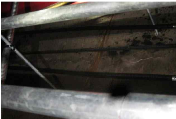
<그림 2.2-6> 도면 지하1층 X9~10-Y03A~Y06A열 콘크리트 이어치기부위 균열상태
