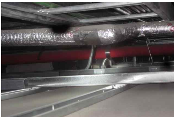
<그림 2.2-4> 도면 지하1층 X9-Y04A열 기둥 철판부착 보강상태(4면 부착)
