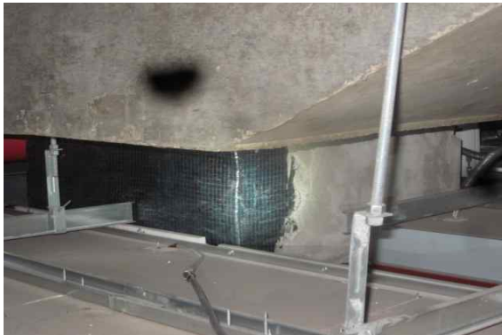
<그림 2.2-2> 도면 지하1층 X7-Y04A열 기둥 탄소섬유 보강상태(1면 부착)
