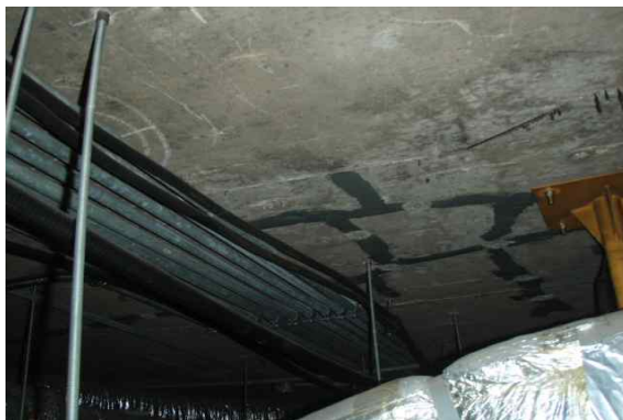
<그림 2.2-2> 도면 지하층 A1~2-Y1~3열 슬래브 균열 보수상태
