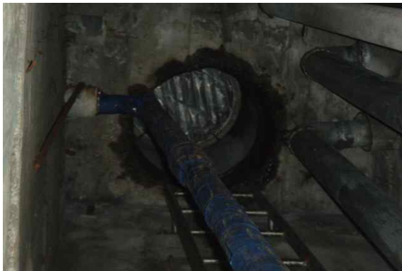
<그림 2.2-9> 오수펌프실 천장 환기구멍 부위 누수상태
