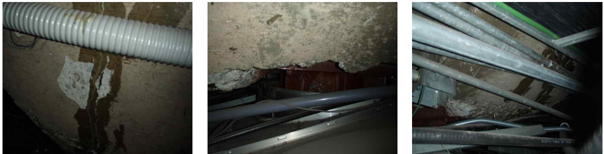
<그림 2.2-6> 도면 지하층 X3-Y5열 기둥 보강 및 기둥 상단 좌, 우측 헌치의 손상, 균열보수 상태(균열 보수 후 재 발생)
