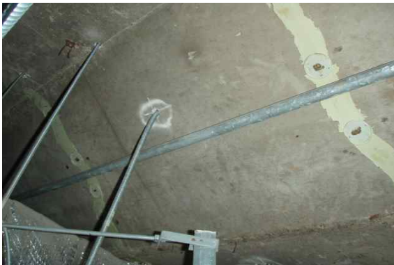
<그림 2.2-1> 도면 지하1층 X14-Y2열 드롭판넬에 발생된 균열 보수 상태
