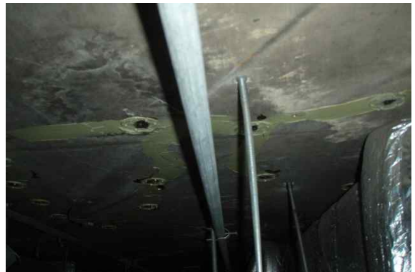
<그림 2.2-2> 도면 지하1층 X24~25-Y2~3열 슬래브에 발생된 균열 보수 상태
