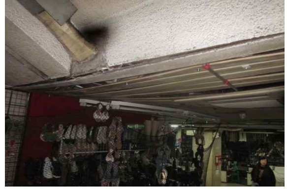
<그림 2.2-8> 상가통로 마감재는 노후 및 변형되어 탈락위험 상태
