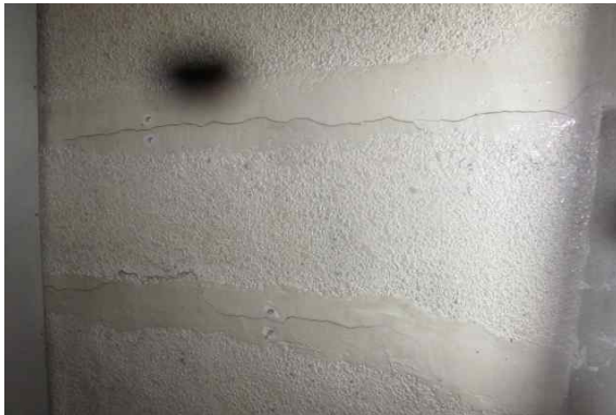
<그림 2.2-1> 도면 지하1층 X1~2-Y1a열 계단실 흡 천장 슬래브 균열 상태
