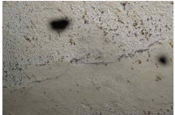
<그림 2.2-2> 도면 지하1층 X11~12-Y1a열 상가 천장 슬래브 균열상태
