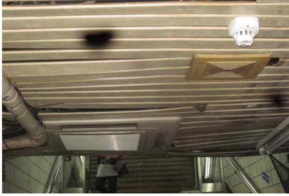
<그림 2.2-8> 상가통로 마감재는 노후 및 변형되어 탈락위험 상태
