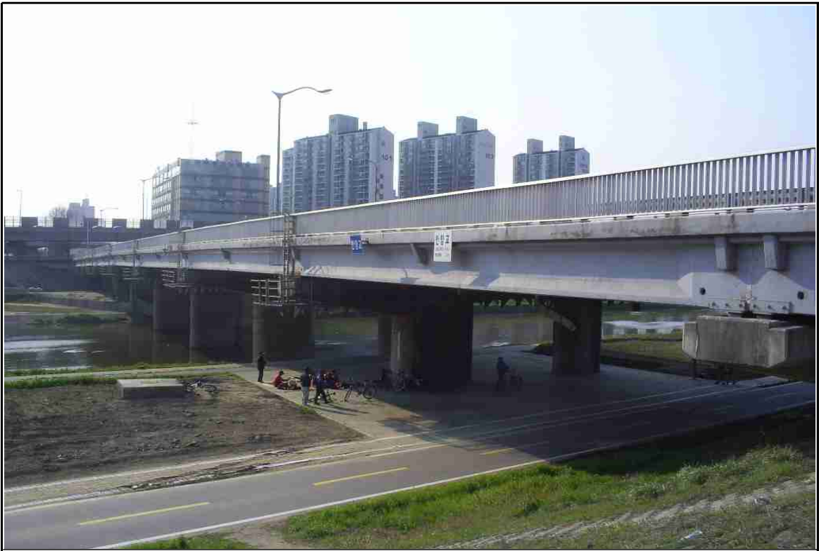
안양교 상부 및 측면전경
