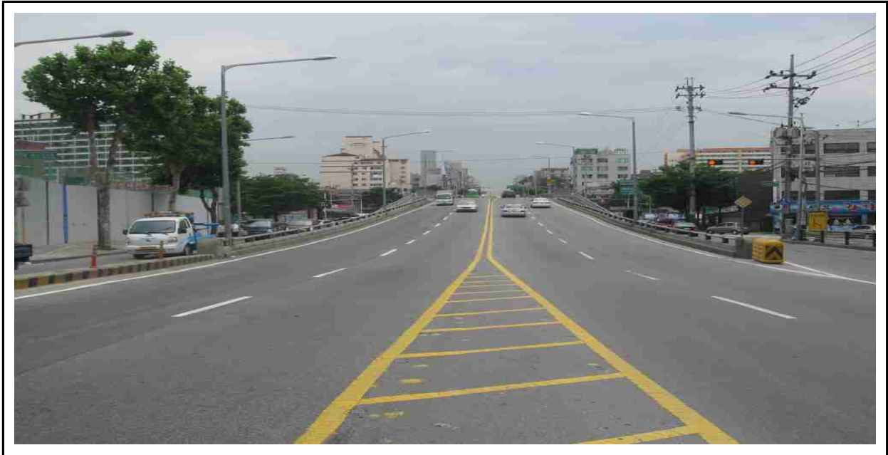
[교량 상면 전경]
