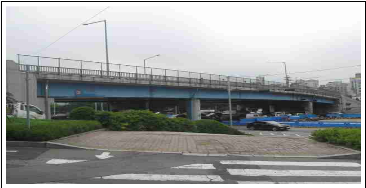
[교량 측면 전경]
