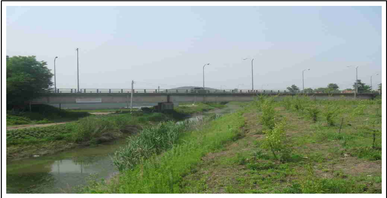
[교량 측면 전경]
