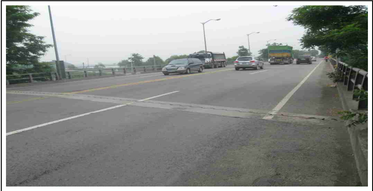
[교량 상면 전경]
