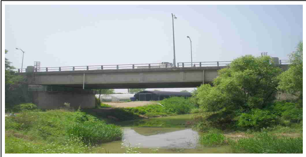
[교량 측면 전경]
