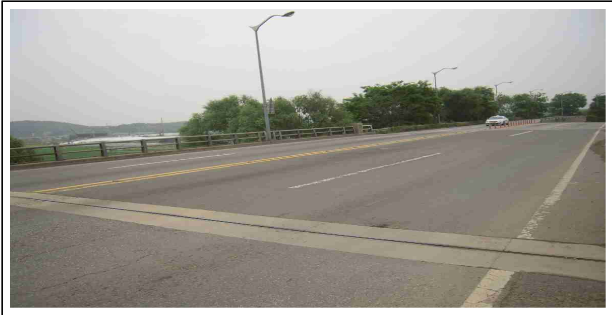
[교량 상면 전경]
