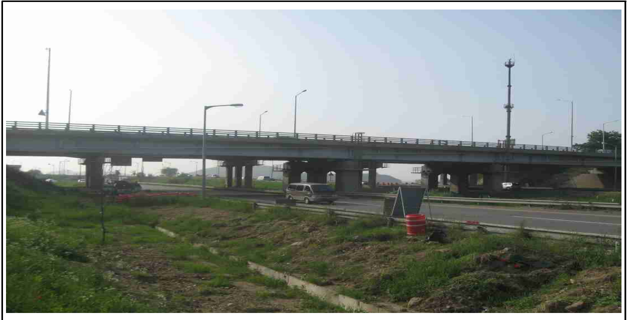
[교량 측면 전경]
