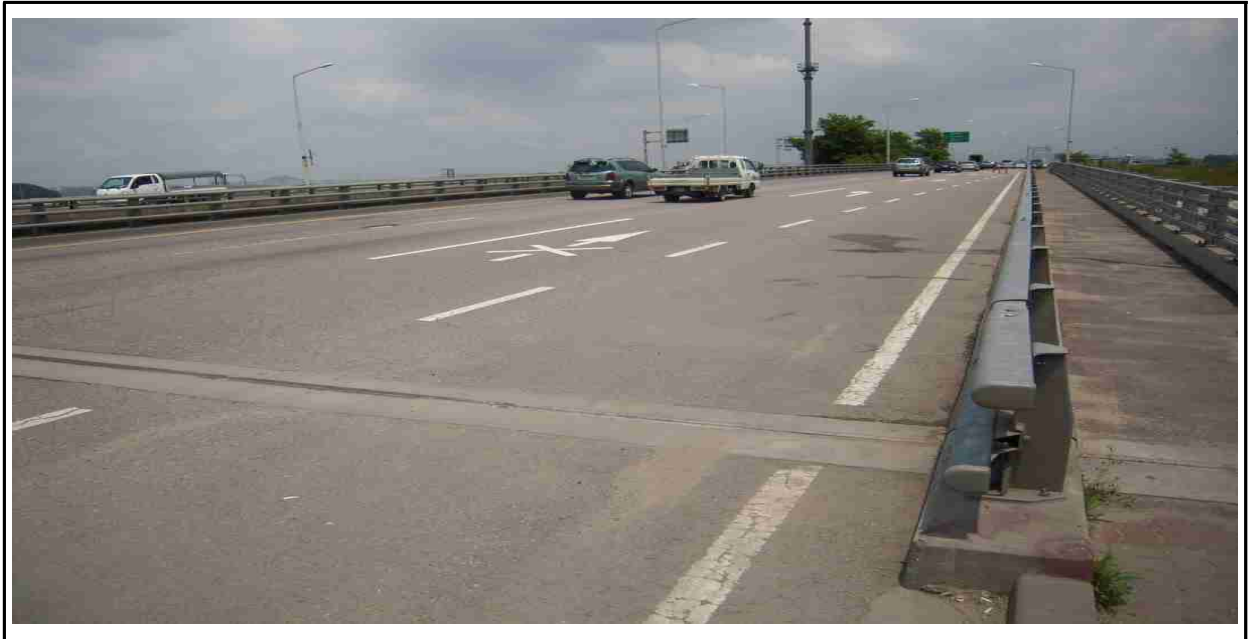
[교량 상면 전경]
