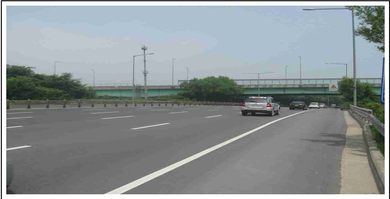
[교량 상면 전경]
