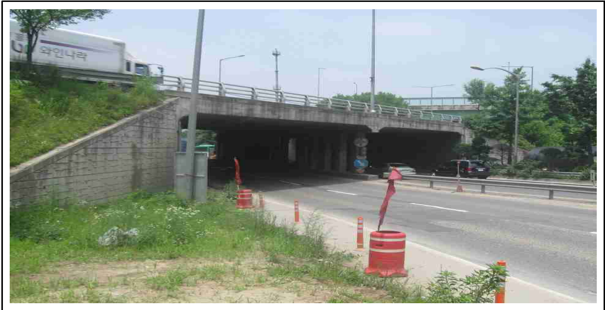
[교량 측면 전경]
