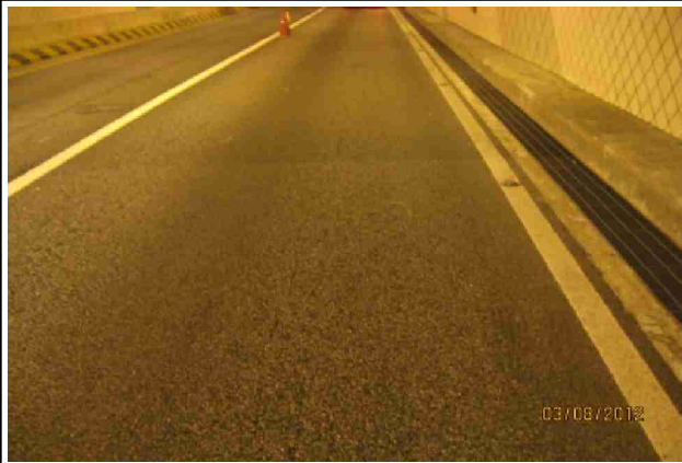
박스내부 포장 전경
