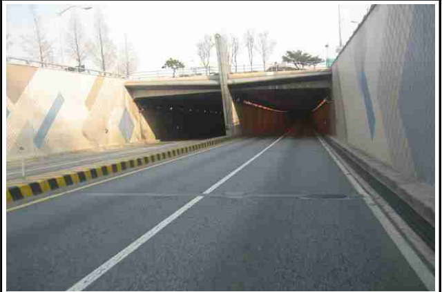
종점측 응벽 전경
