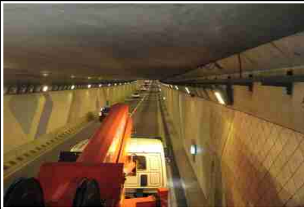
BOX 내부 천정슬래브 전경
