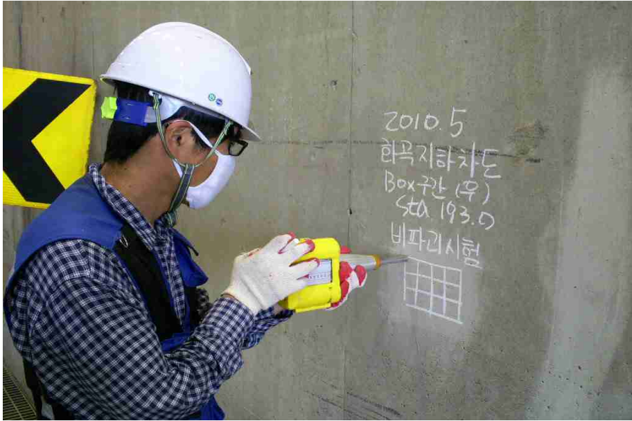
사진내용 슈미트햄머를 이용한 비파괴강도 측정 전경
