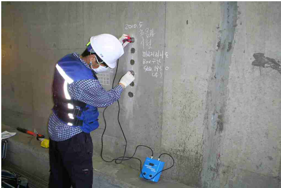
사진내용 초음파 측정기를 이용한 콘크리트 강도시험 전경
