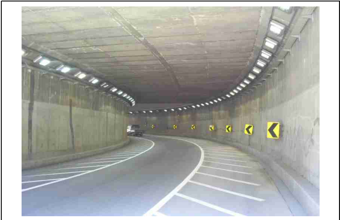
화곡지하차도 입구 및 내부전경
