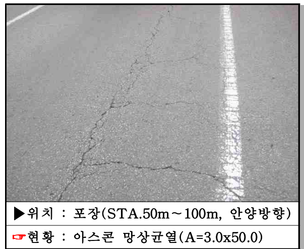
【사진 3.2.5】 바닥부(아스팔트포장, L형측구, 경계석) 외관조사 현황
