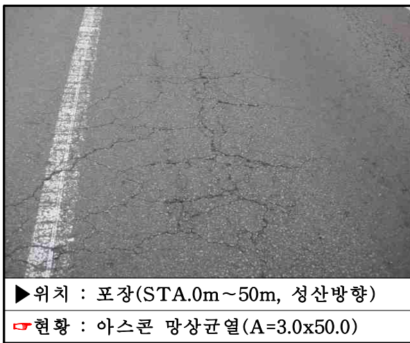
【사진 3.2.5】 바닥부(아스팔트포장, L형측구, 경계석) 외관조사 현황
