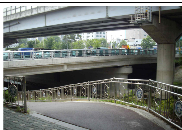
교량 측면 전경
