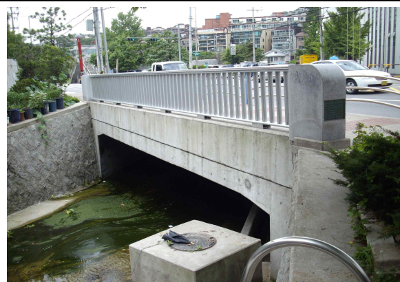
교량 측면 전경
