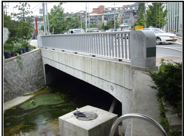
진형교 측면 전경
