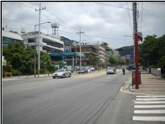
진형교 상부 전경
