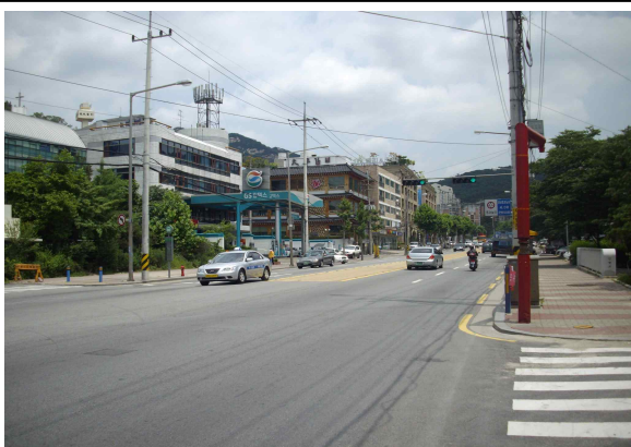
교량 상부 전경
