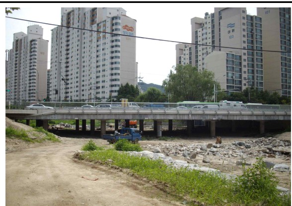
교량 측면 전경
