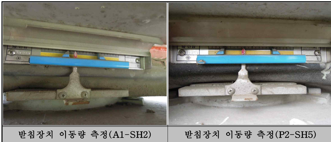
【그림 2.3】 받침장치 이동량 측정 전경
