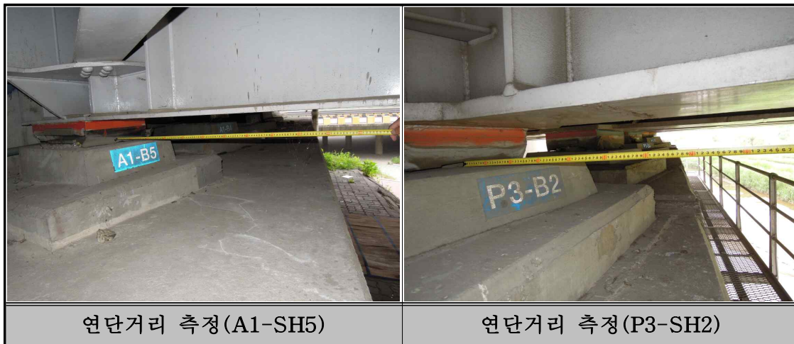
【그림 2.2】 연단거리 측정 전경
