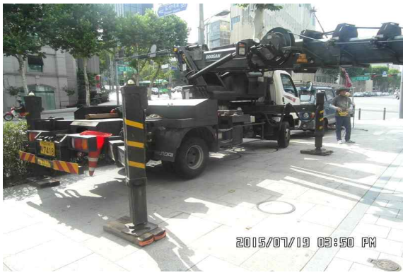
건설관리과 - 도곡로 포크레인 보도위 작업
