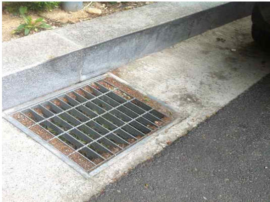
홍은동 옥천소공원 앞 거주자 주차구역 41-4 (막힘)
