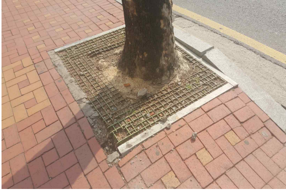
도로관리과 - 강남역 가로수보호틀 파손
