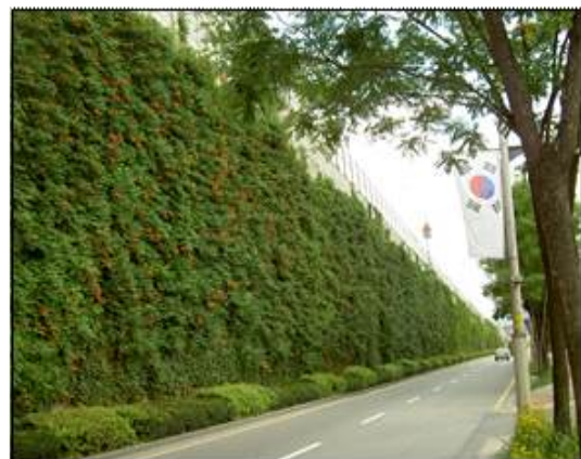
광진구 청담대교 진입로 옹벽(조성후)
