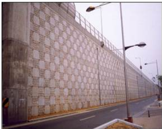
광진구 청담대교 진입로 옹벽(조성전)
