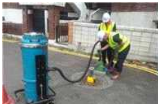
2. 집진기를 이용한 포장 절단
