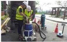
8. 집진기를 이용한 몰탈 혼합
