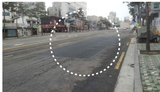
차로폭 복구사례(침하, 균열 우려없음)
