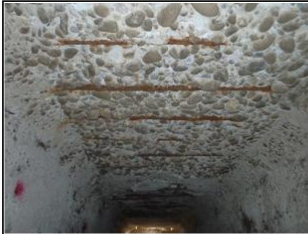
3라인 52.0m 상부슬래브 철근노출
