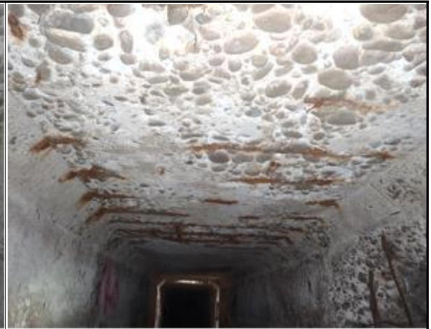
3라인 134.5m 슬래브 및 벽체 철근노출
