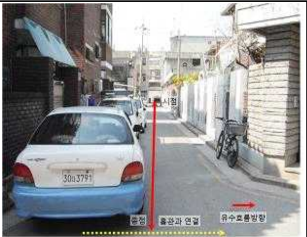
7라인 종점부 상부전경
