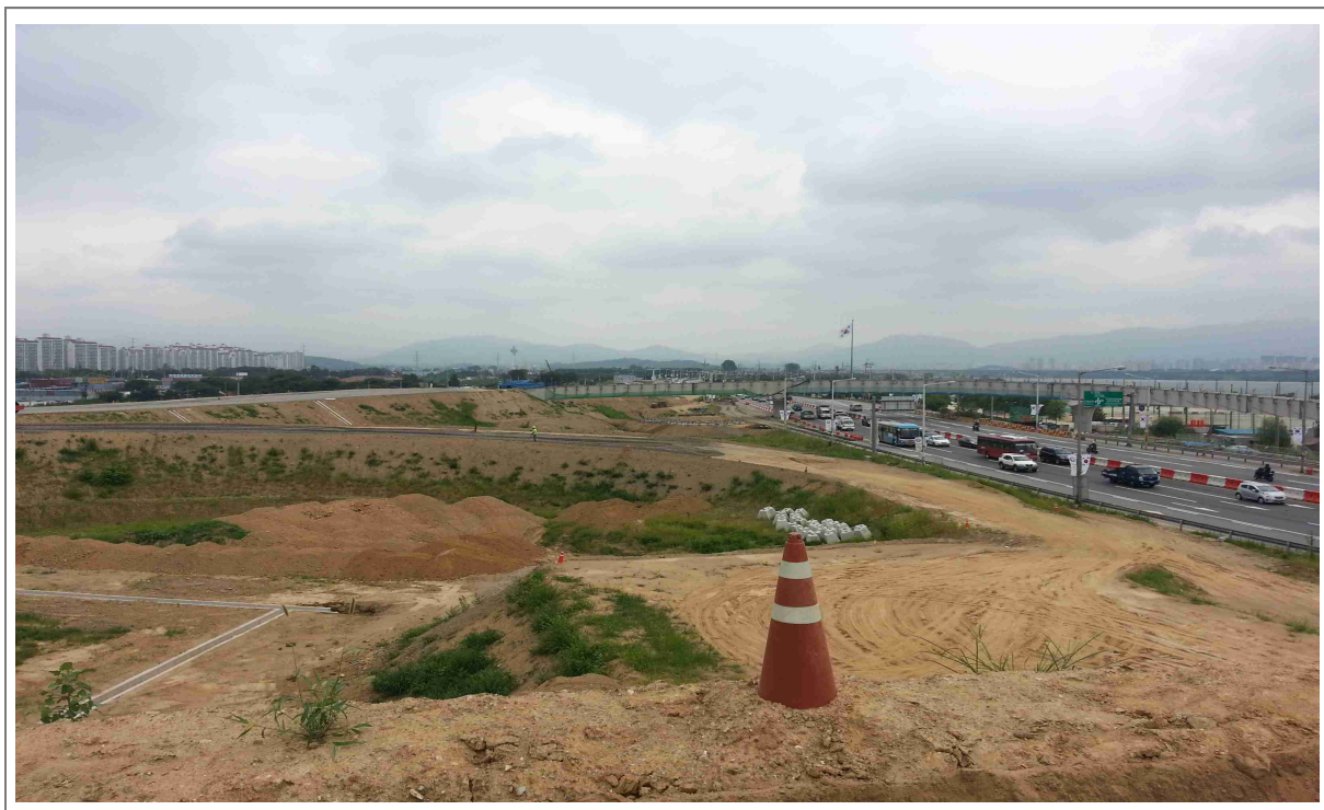
아천IC교량 전경 (Ramp-G)
