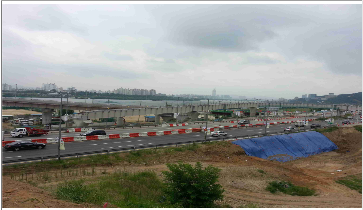
아천IC교량 전경 (Ramp-F)
