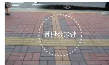
보도 부분복구사례(침하, 교면 균열 우려)
