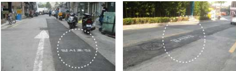
“임시포장” 노면 페인팅(관리기관·공사 시공자를 알 수 없음)
