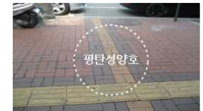
보도전폭 복구사례(침하, 균열 우려없음)
