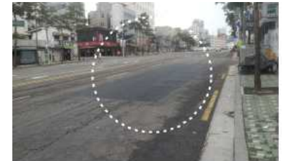
차로폭 복구사례(침하, 균열 우려없음)
