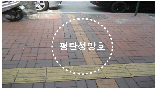
보도전폭 복구사례(침하, 균열 우려없음)
