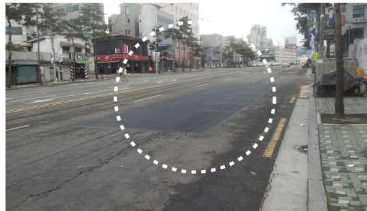
차로폭 복구사례(침하, 균열 우려없음)
