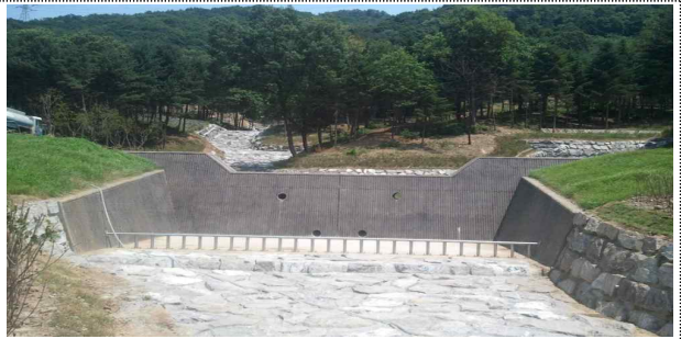
< 하부 맹암거형 사방댐 설치 >
