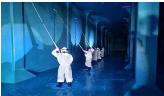
▲ 배수지 벽체 세척 작업
