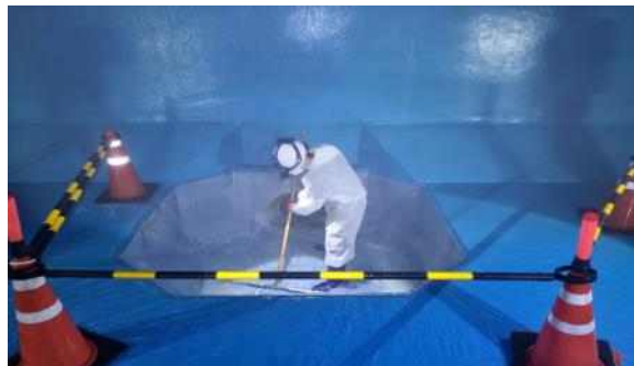
▲ 배수지 바닥 세척 작업
