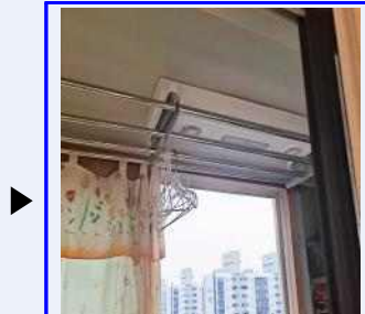
전동 빨래 건조대 설치 후
