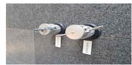
청소용 고정배관 설치
