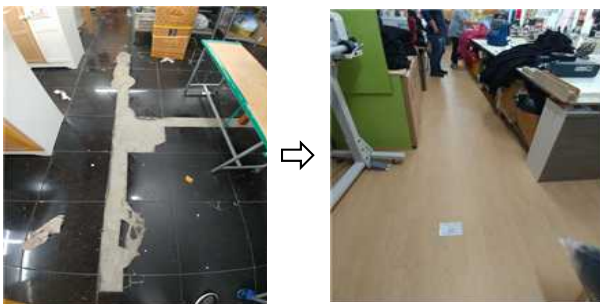
< 변경 전 > < 변경 후 > 작업환경개선(바닥개선공사)
