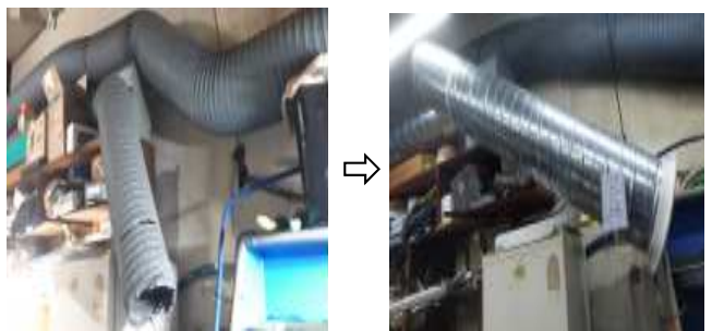
< 변경 전 > < 변경 후 > 작업환경개선(덕트, 공기질개선)
