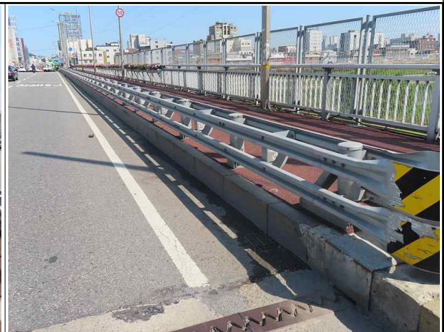
보차도 경계부 가드레일 전경
