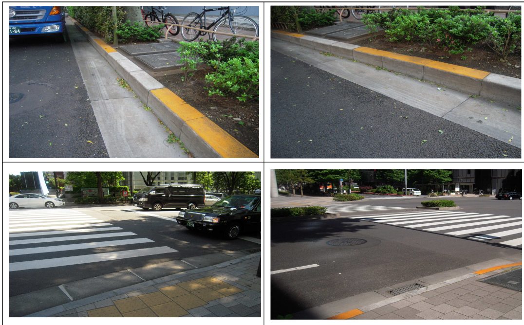
< 동경도 PC측구 시공사례 >
