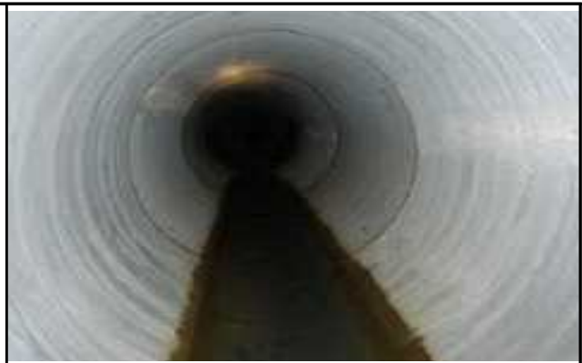
하수시설물 개량 후
