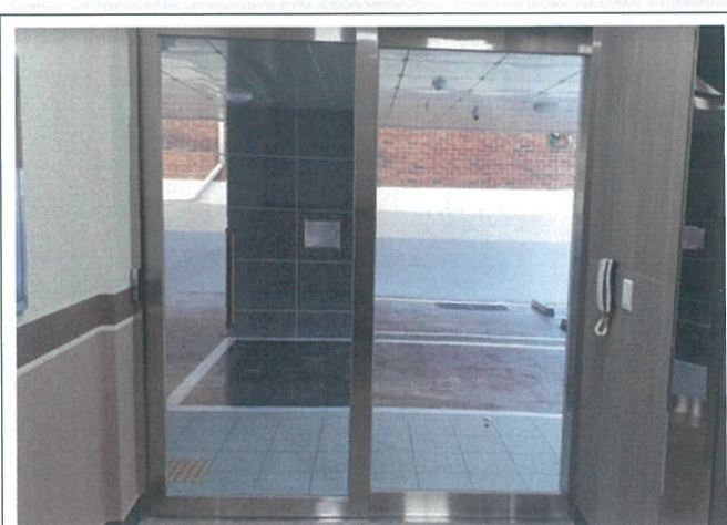
동출입구 현관 전경(내부)
