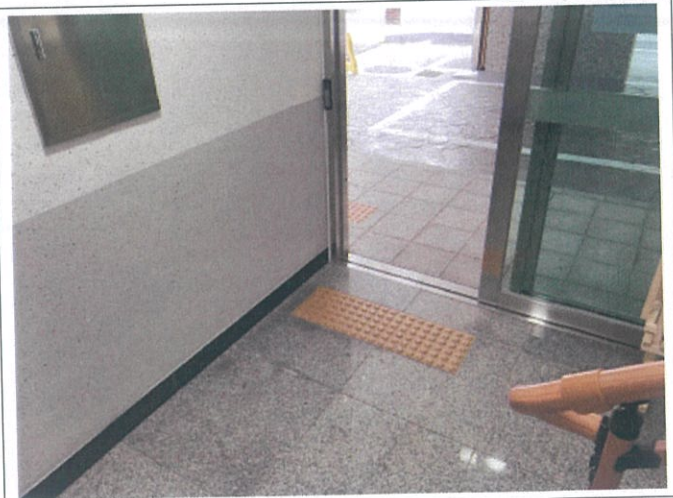
동출입구 현관 전경(내부)
