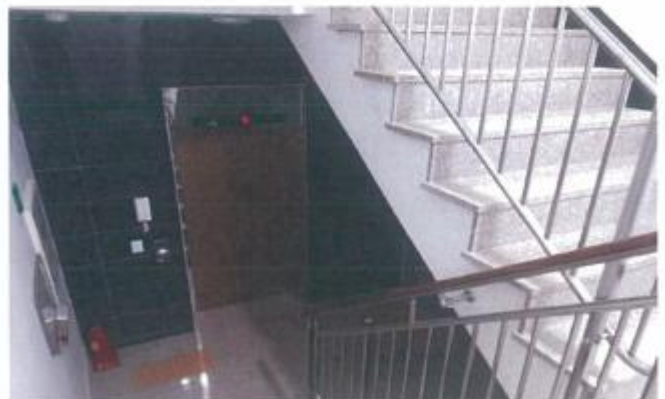
동출입구 현관 전경(내부)
