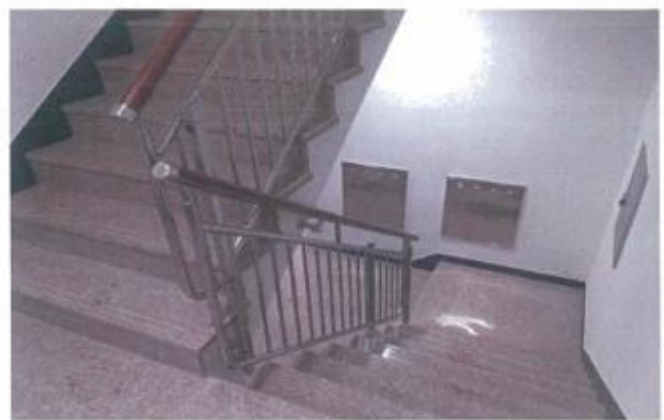
동출입구 현관 전경(내부)
