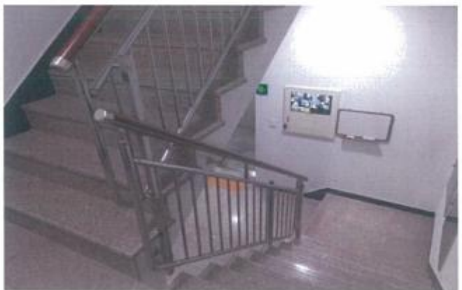
동출입구 현관 전경(내부)
