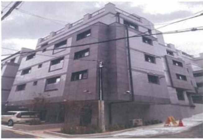
건물 외부 전경
