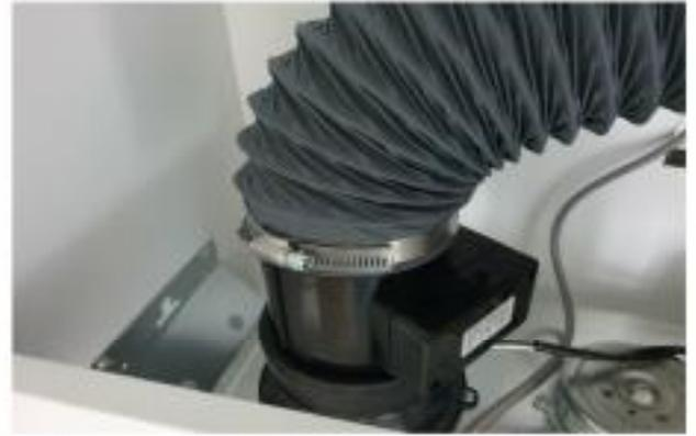
사진6-1. 전동식 탐파 설치
