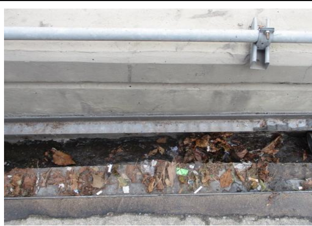
4-1: 동일로지하차도 배수로 청소
