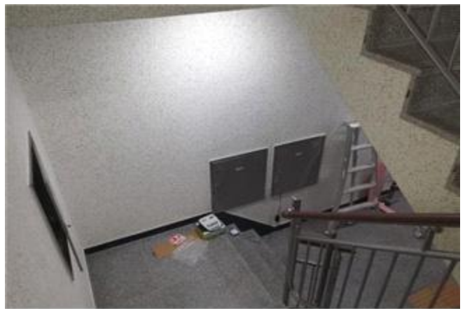
동출입구 현관 전경(내부)
