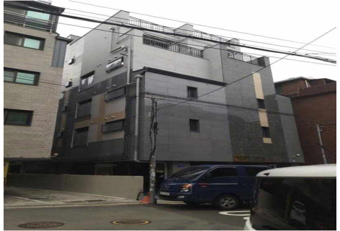
건물 외부 전경
