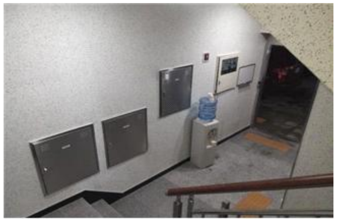
동출입구 현관 전경(내부)
