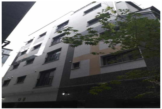
건물 외부 전경
