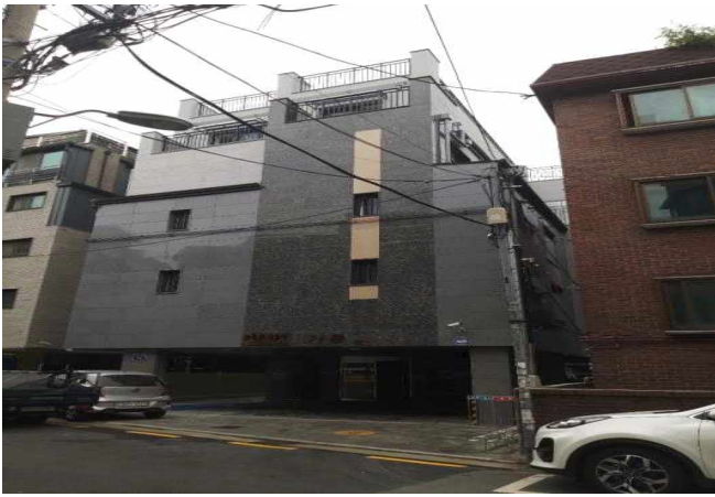
건물 외부 전경
