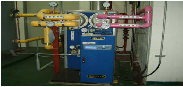
도봉차고지(15만Kcal/h, '08.06설치, 부스터)
