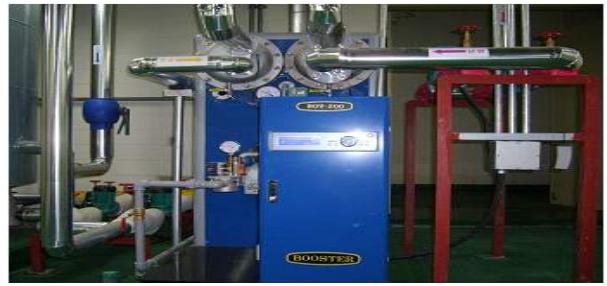
강서차고지(20만Kcal/h, '08.10설치, 부스터)
