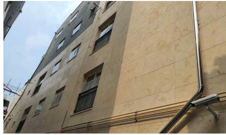
건물 외부 전경
