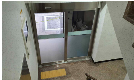
동출입구 현관 전경(내부)
