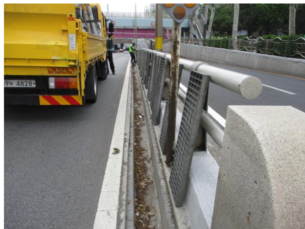
4-1: 배수로 청소(동일로지하차도, 양방향)
