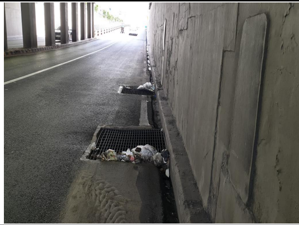
3-1: 배수로 및 집수정 정비(군자교동축지하차도, 양방향)
